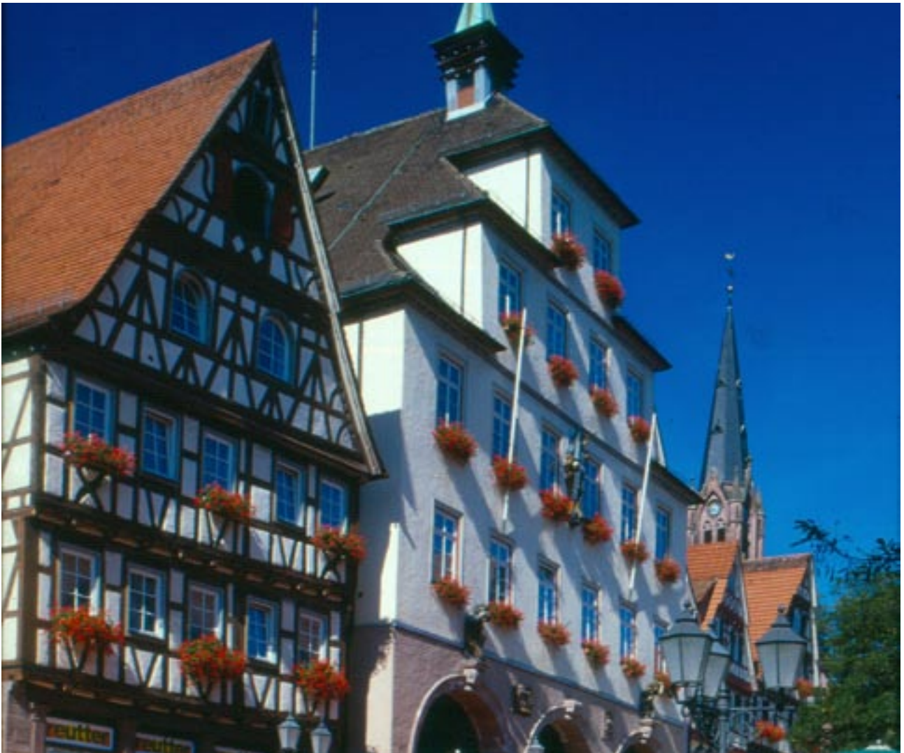
Das Calwer Rathaus – wegen Einsturzgefahr geräumt
